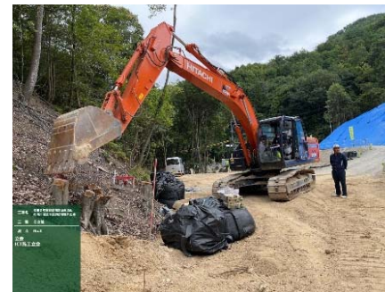
ICTバックホウを用いた掘削状況
